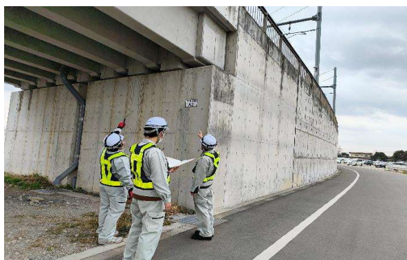
【構造物の点検方法の確認の様子】
