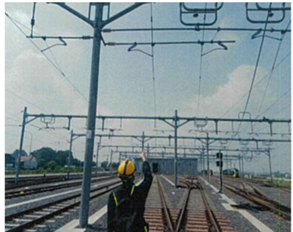
【電車線路設備巡視点検】
