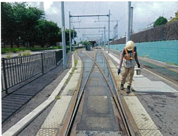
【軌道巡視点検】
