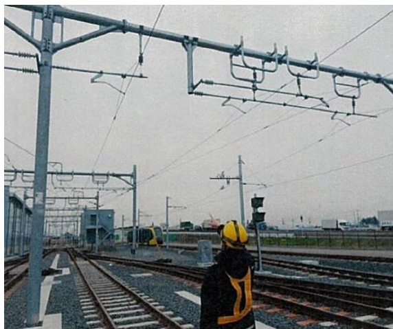
【電車線路設備巡視点検】
