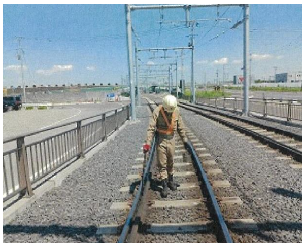
【軌道巡視点検】
